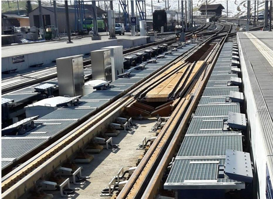
Die zwei parallelen Umspuranlage in Zweisimmen: innerhalb der Vierschienengleise je eine Stahlplatte mit Nuten, von denen aus das Umspuren der Drehgestelle während der Fahrt automatisch vorgenommen wird. Daneben: die heruntergeklappten, mit Gitterblechen verdeckten Rampen. Hintergrund: das gradeaus führende Stumpfgleis
